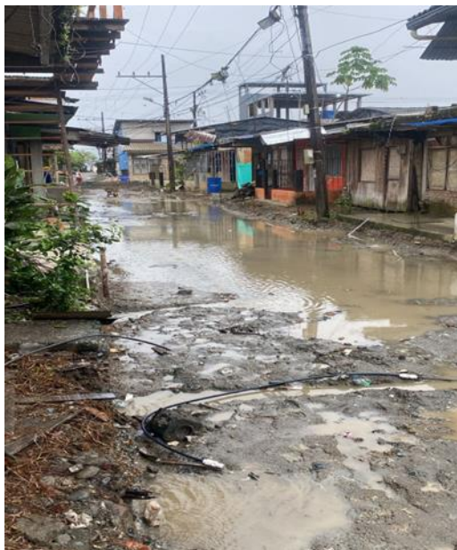
Estado inicial de la vía
