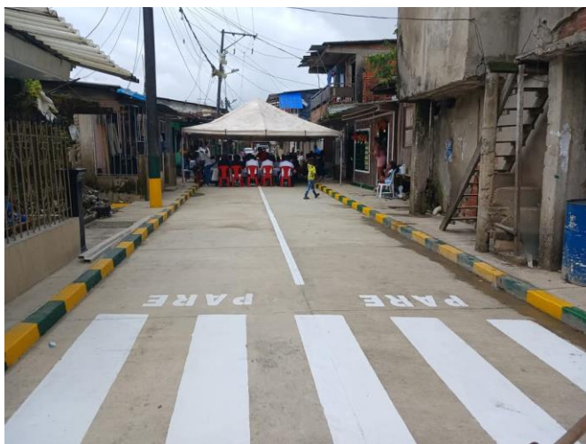
Terminacion de la obra y entrega a la comunidad
