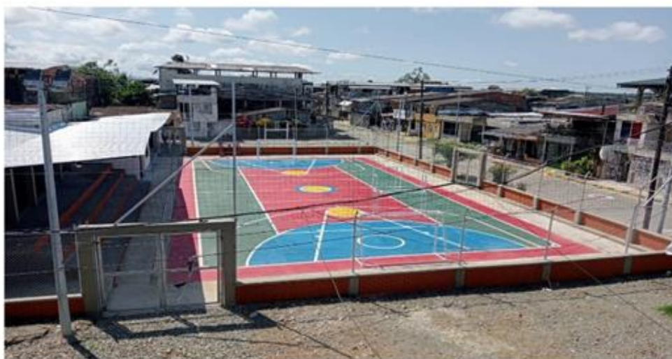
Terminación y entrega de la obra
