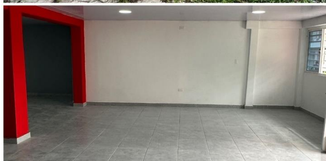
Adecuación del salón general
