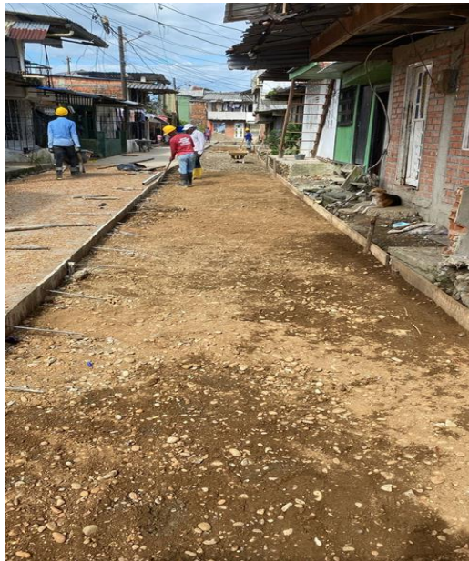
avance de ejecucion de obra
